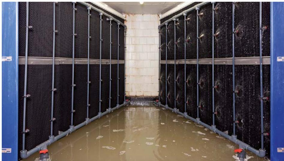
Vorderseite der Filterwand: Düsengruppe sprüht in Abständen Wasser auf die Filterwand
