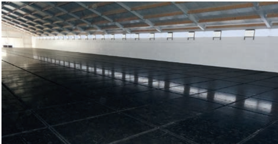
Blick auf die aus Kunststoff-Platten bestehende Zwischendecke vor der Montage der Anlage in der zweiten Ebene
