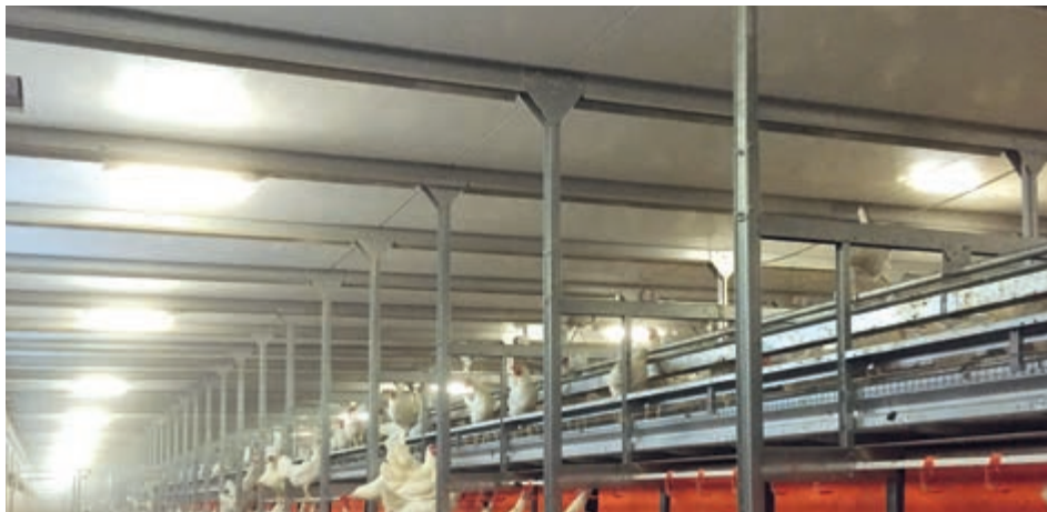
Die weiße und glatte Unterseite der Kunststoff-Platten ermöglicht den ungehinderten Zuluftstrom in Stallquerrichtung und sorgt außerdem für mehr Helligkeit in der unteren Ebene
