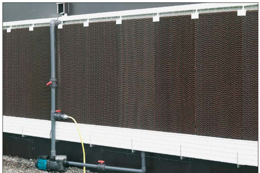
Kreiselpumpe inkl. Filter und Bleed off
