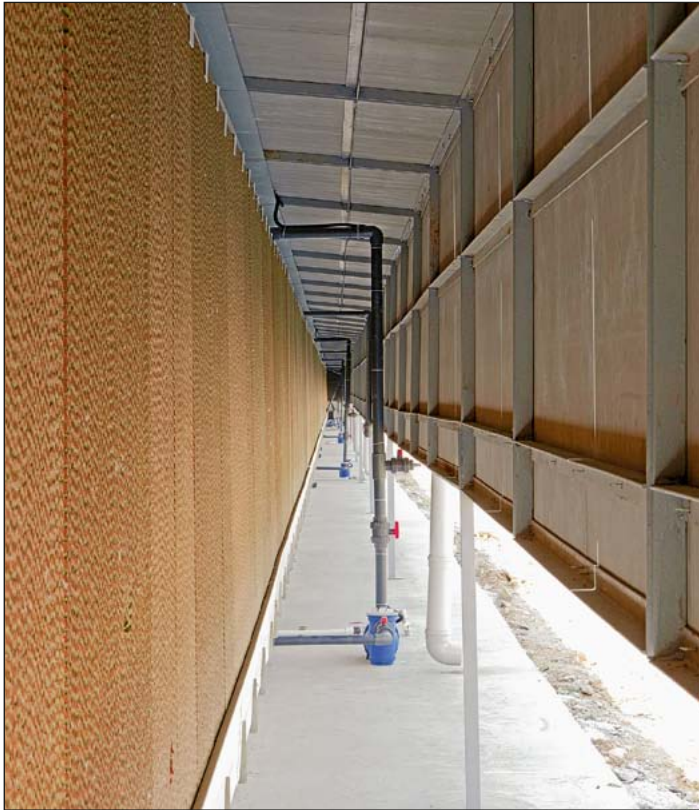
Wind- und Staubschutz sowie keine direkte Sonneneinstrahlung auf das Pad
