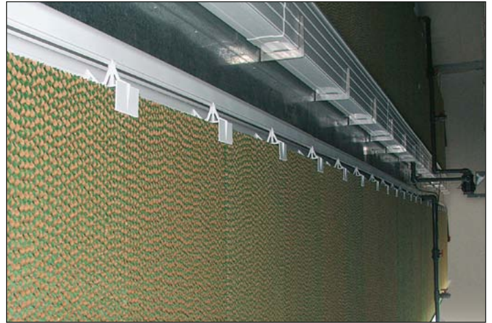
Doppeltes RainMaker-System für hohe Käfigställe
