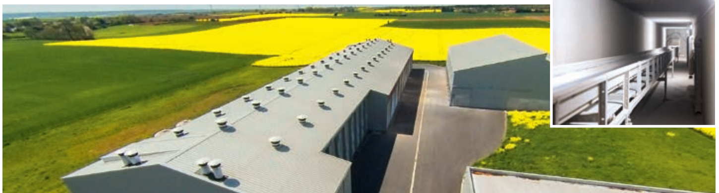
Umweltfreundliche Lösung: 2 OptiPlate für 205.000 Legehennen an der Stall-Längsseite; der getrocknete Kot wird unterirdisch ins Kotlager transportiert
