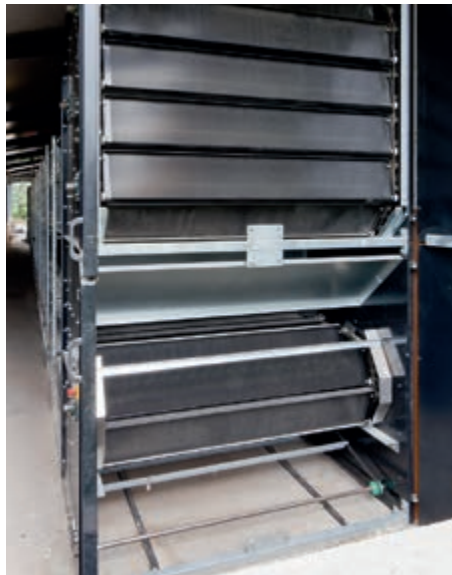
OptiPlate geöffnet mit Staubkratzer
