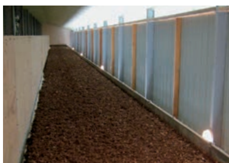
Blick auf die oberste Etage
