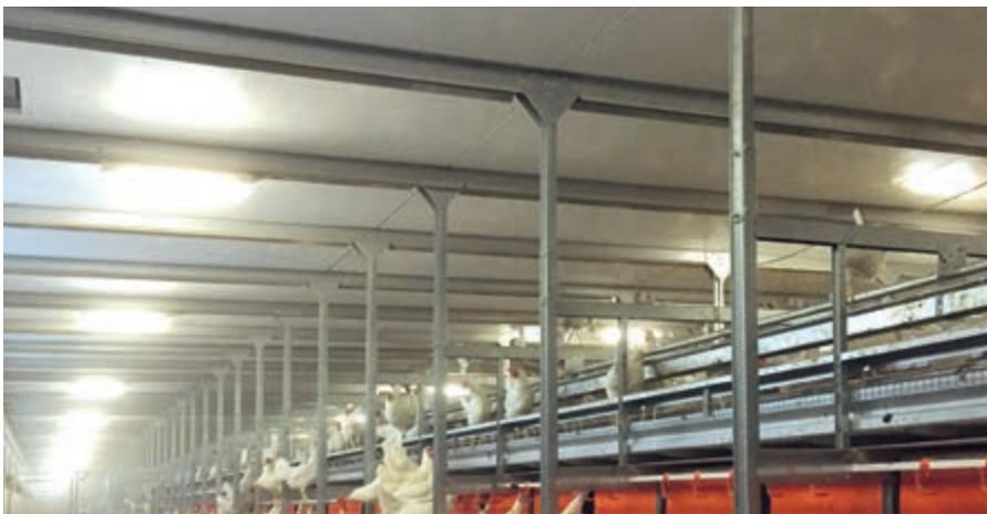
Die weiße und glatte Unterseite der Kunststoff-Platten ermöglicht den ungehinderten Zuluftstrom in Stallquerichtung und sorgt außerdem für mehr Helligkeit in der unteren Ebene
