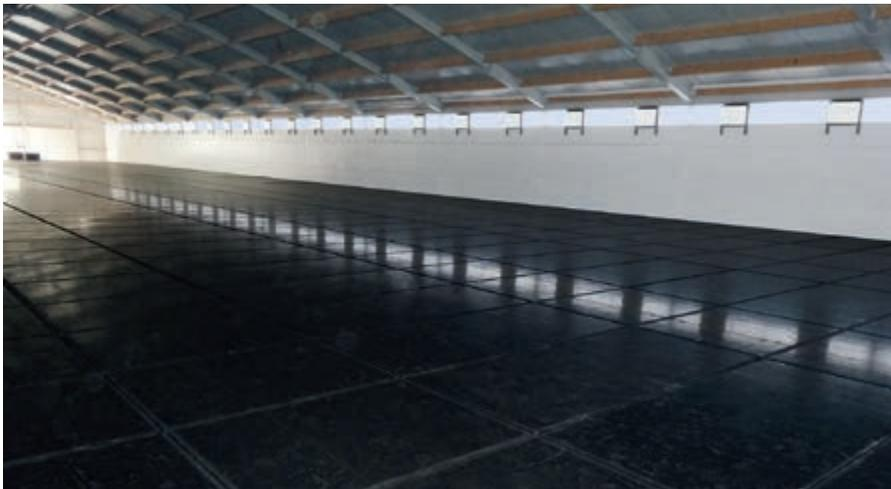
Blick auf die aus Kunststoff-Platten bestehende Zwischendecke vor der Montage der Anlage in der zweiten Ebene
